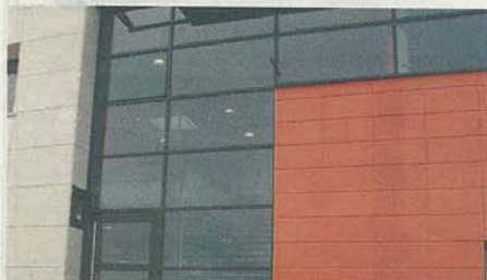
A l'entrée du bâtiment administratif, terre cuite rouge et céramique blanche d'Imola (Italie) se côtoient avec harmonie.
