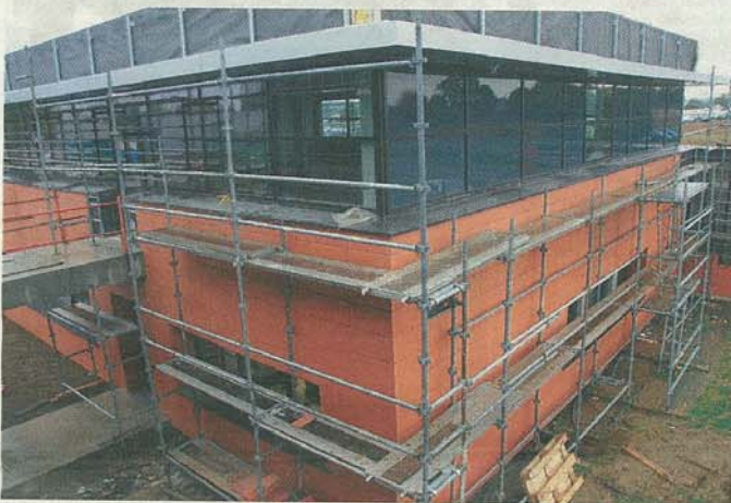
Des panneaux de terre cuite constituent pour partie l'enveloppe extérieure du bâtiment.
